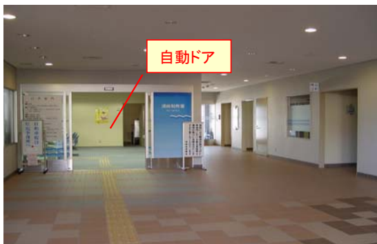
事務室入口自動ドア化
