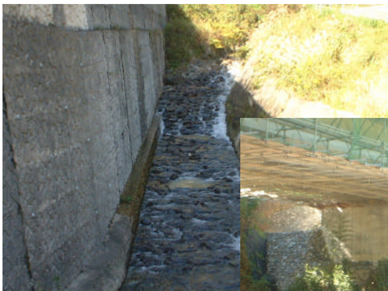
底板石張り水路
