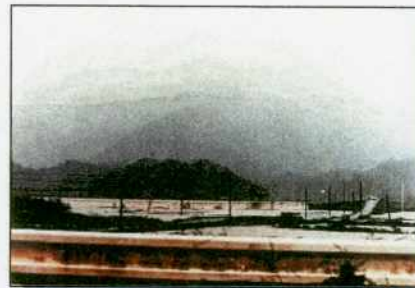
中筋川越水状況(有岡地区)
