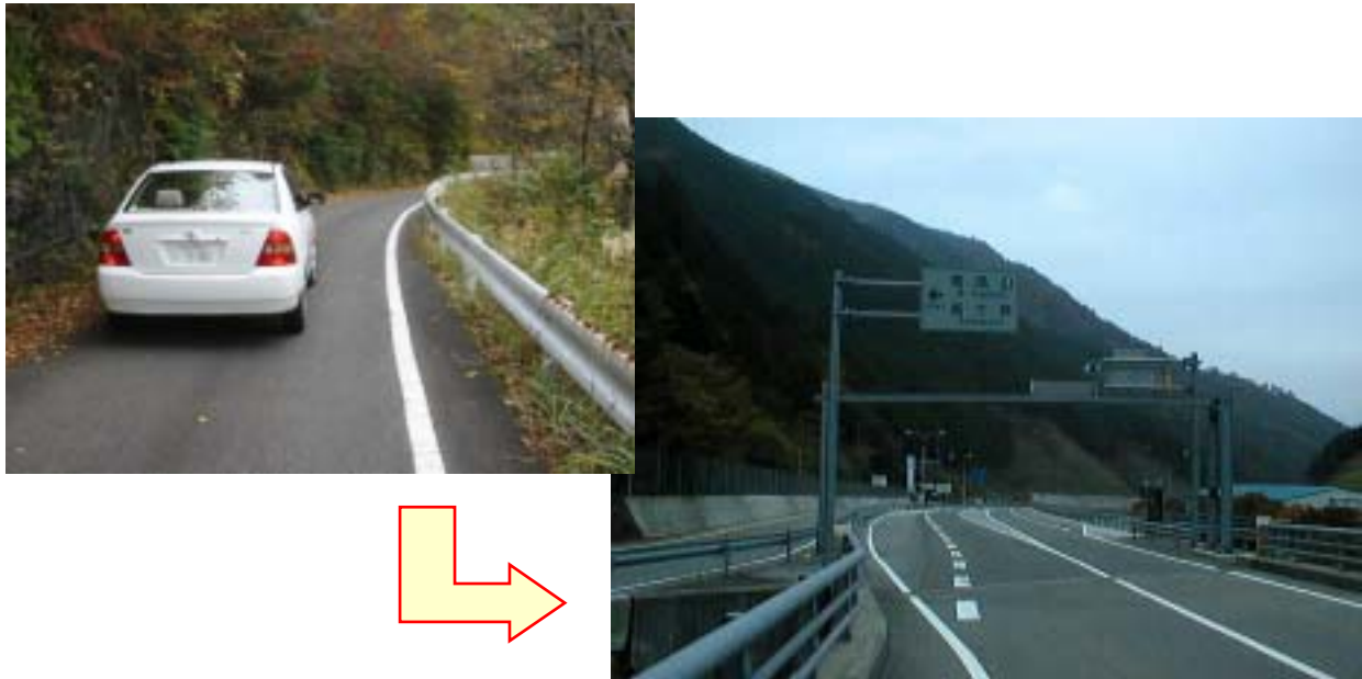
図 15 狭小幅員の解消状況
