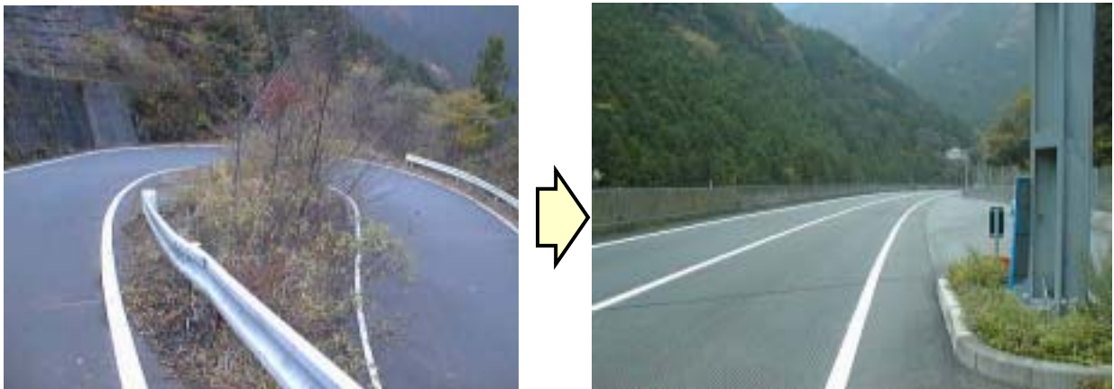
図 22 寒風山道路の整備より急カーブが解消された様子
