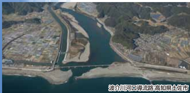
新宇治川放水路(呑口):高知県吾川郡いの町
