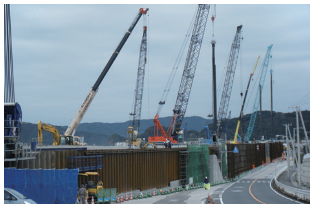
二重矢板施工状況 (新居工区)
