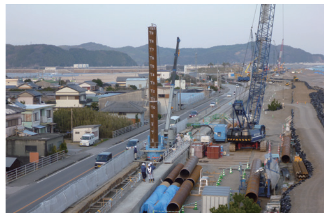
鋼管杭施工状況 (新居工区)
