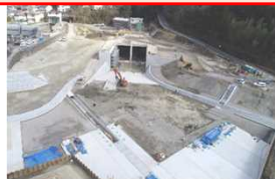
香口導水路施工状況
