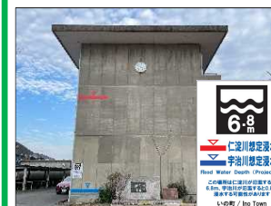
想定浸水深表示板を設置
