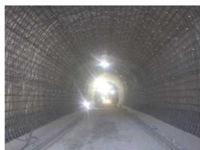
吐口側作業坑施工状況
