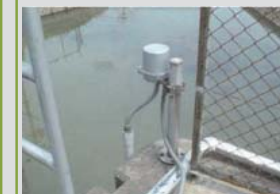
水位計の設置
