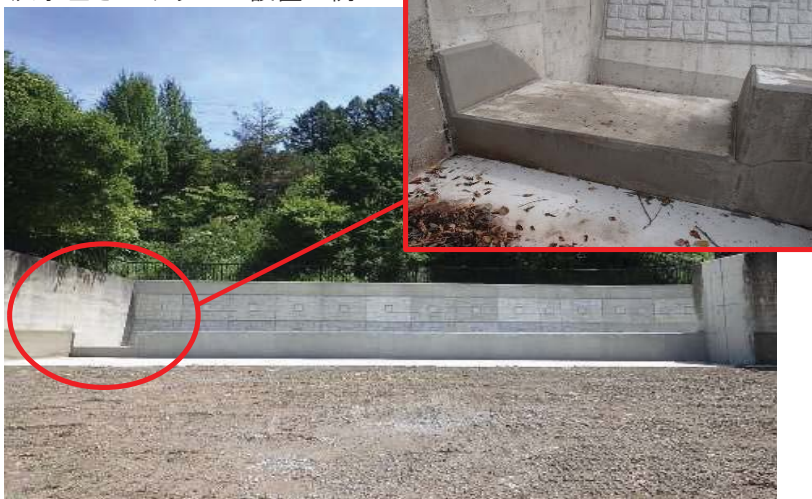
洪水吐きスリットの設置の例
