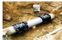
漏水防止のための整備
