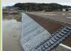
ため池護岸の整備
