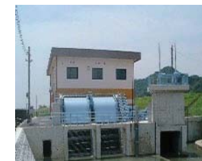
排水機場の整備
