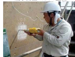
老朽化した施設の機能診断
