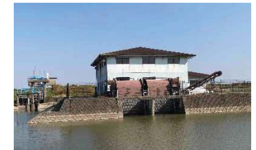
(排水機場整備)
