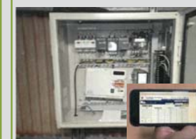
監視装置の設置
