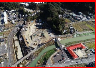
放水路整備（日下川新規放水路）
