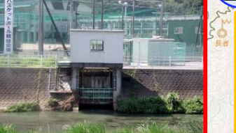
呑呑雨水貯留浸透施設（いの町）
