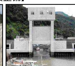
津波・高潮対策としての水門整備
