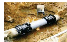
漏水防止のための整備
