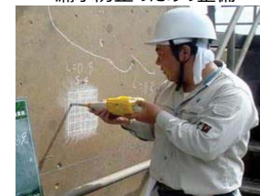
老朽化した施設の機能診断
