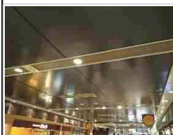
天井板の耐震改修
