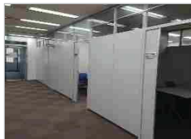
仕切り壁の設置
