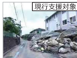
宅地擁壁等の危険度調査等
