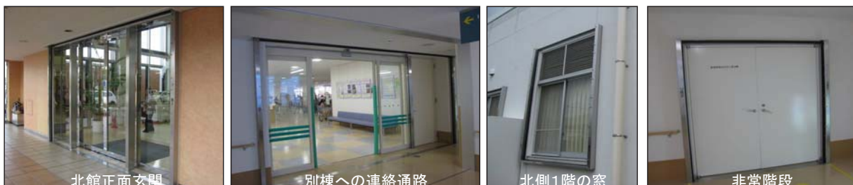
止水板のための角落としの設置
