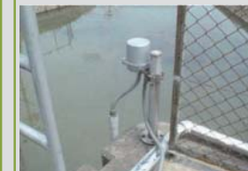
水位計の設置
