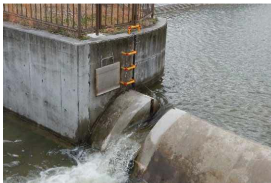
洪水吐きスリットの設置の例
