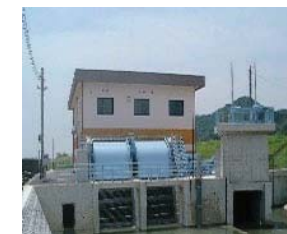
排水機場の整備
