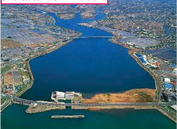
排水機場と周辺の市街地
