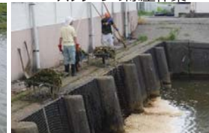
スクリーンの除塵作業
