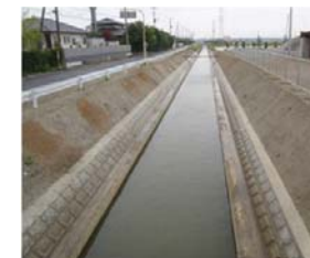
排水路の整備
