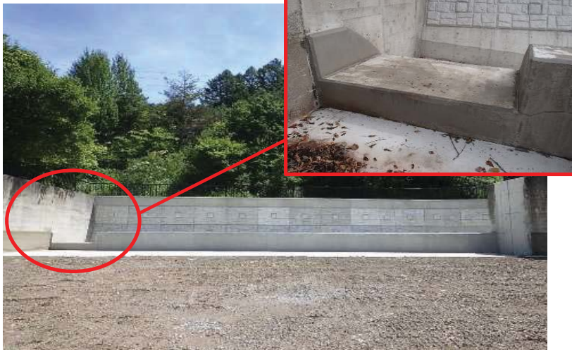
洪水吐きスリットの設置の例
