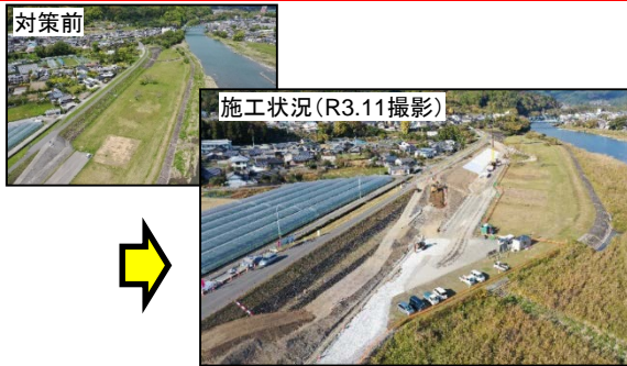
小田島地区堤防拡幅
