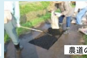
水路のひび割れ補修
