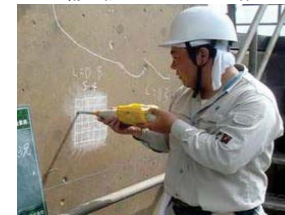
老朽化した施設の機能診断
