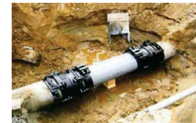
漏水防止のための整備
