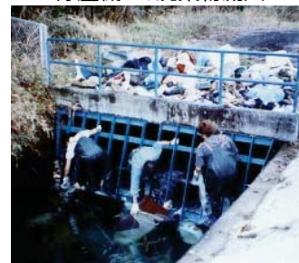
除塵機への廃棄物流入
