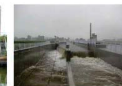
(排水分水ゲート)
