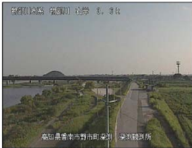
▲平常時の物部川橋付近 平常時の深淵水位観測所水位：約0.5m
