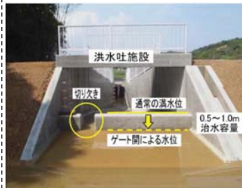
指定貯水施設(ため池)での 事前放流施設整備の事例
