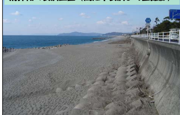
清掃後の長浜工区(高知市長浜より西撮影)
