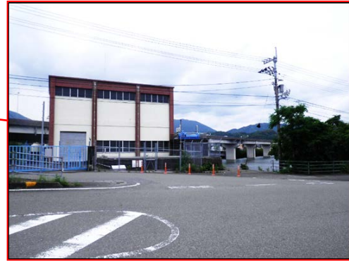
（桐間第2排水機場）
