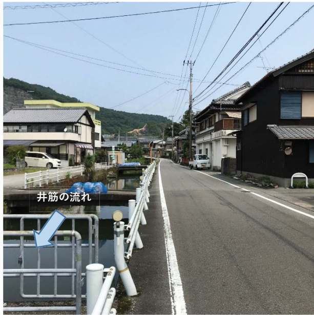
被害写真番号①（土佐市吹越地区）
