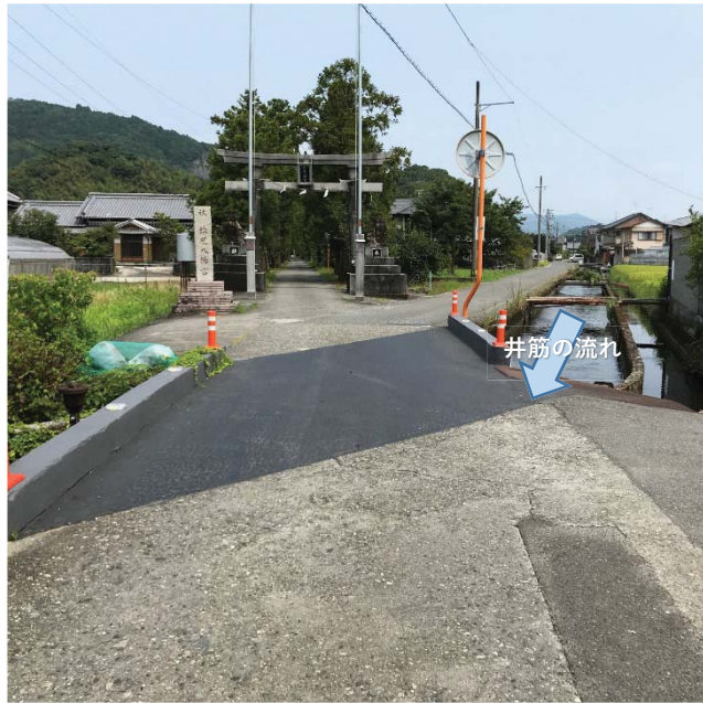
被害写真番号④（土佐市八幡地区）
