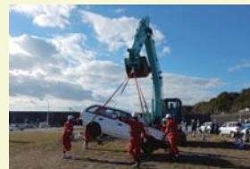
道路啓開訓練
