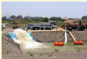
浸水排除訓練
