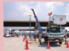
配電線復旧訓練
