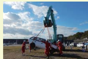
道路啓開訓練
