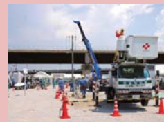
配電線復旧訓練
