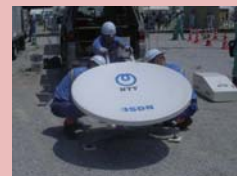
通信応急復旧訓練
