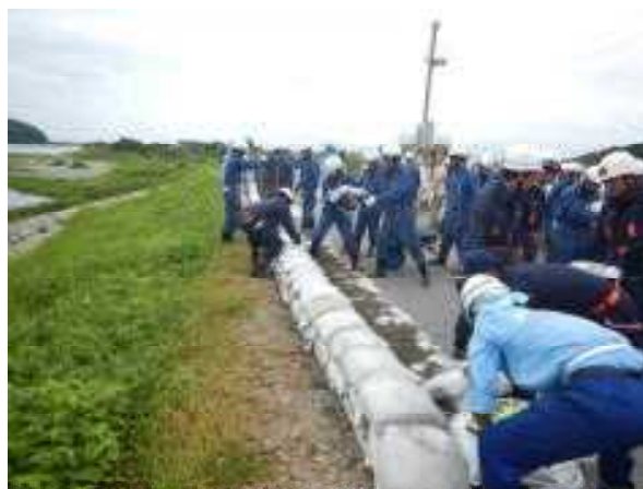
越水対策(積土のう工)
