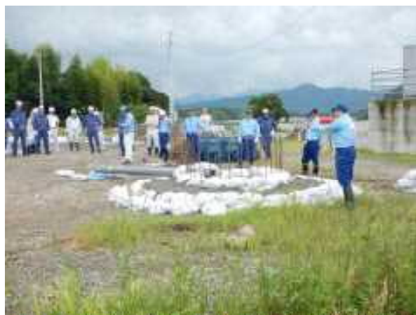
漏水対策(釜段工)
