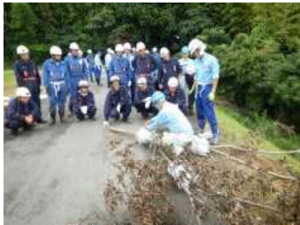
洗掘対策(木流し工)
