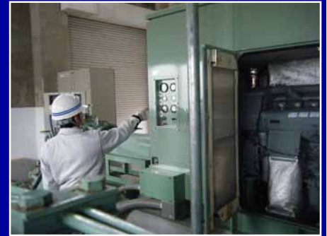
排水門点検状況
