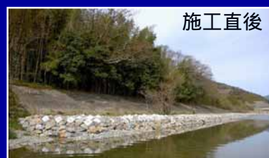
低水護岸覆土の設置状況
