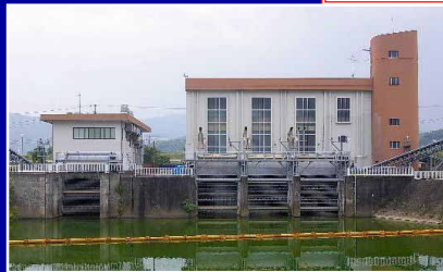
宇治川排水機場
