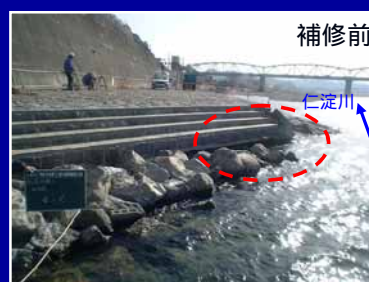
護岸の補修状況
