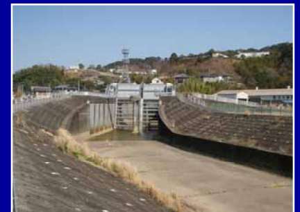
日下川放水路(呑口部)
