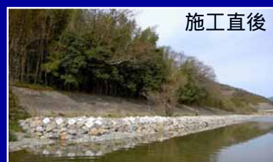
低水護岸覆土の設置状況
