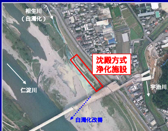
白濁化改善の状況(仁淀川相生浄化施設)
