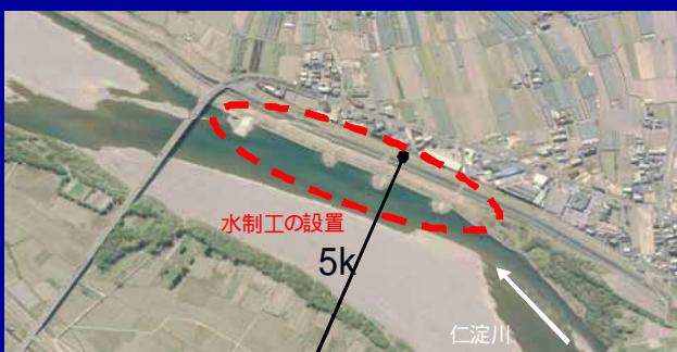
水衝部の対策状況
