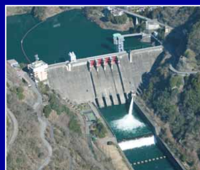
大渡ダム(昭和61年完成)
