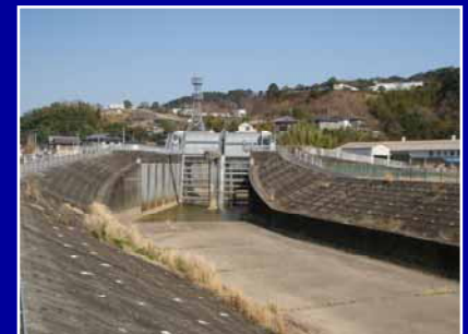
日下川放水路(呑口部)
