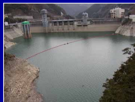
渇水時の大渡ダム(平成17年)
