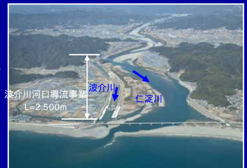
波介川河口導流堤
