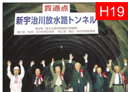
新宇治川放水路トンネル完成 (H19.2.24)
