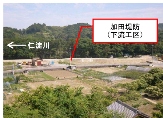
図5.2 築堤実施状況（加田箇所）
