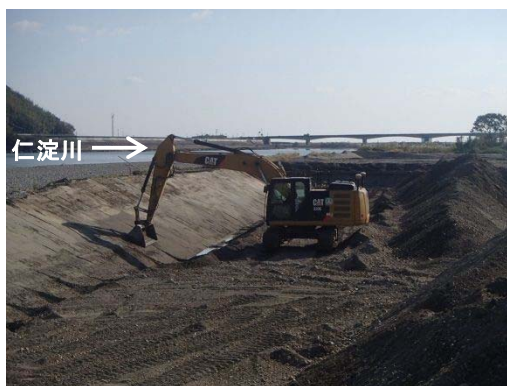
図5.1 河道掘削実施状況（新居箇所）
