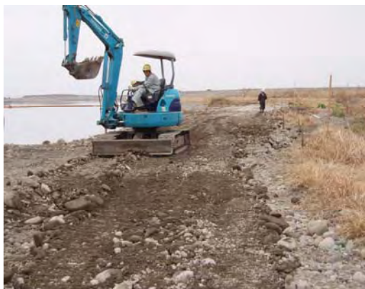
河道整正状況 (河口より0.4km付近左岸側)
