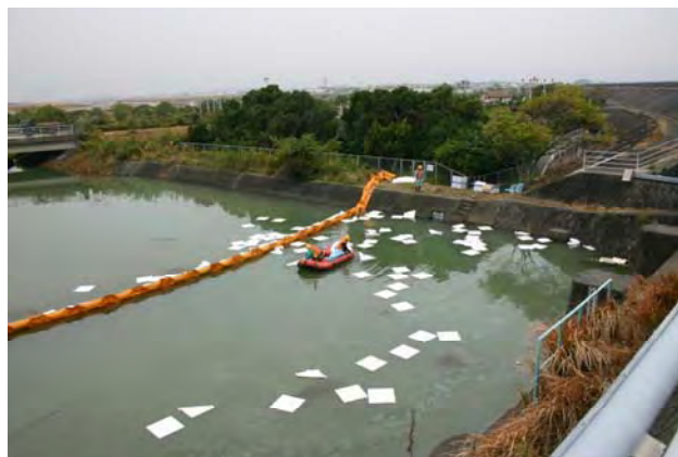
水質事故への対応（後川：物部川合流点） 重油流出事故に対してオイルフェンスにより拡散を防止
