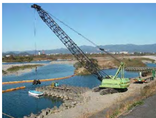
被災箇所の災害復旧
