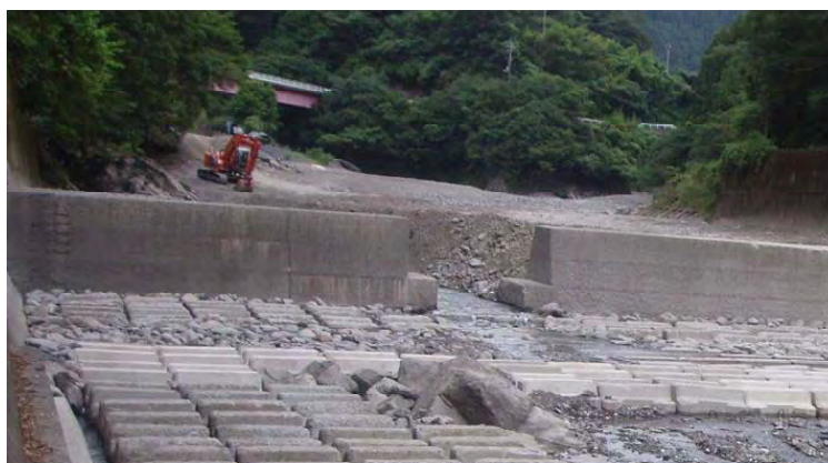
堆砂除去の状況（佐岡貯砂ダム）
