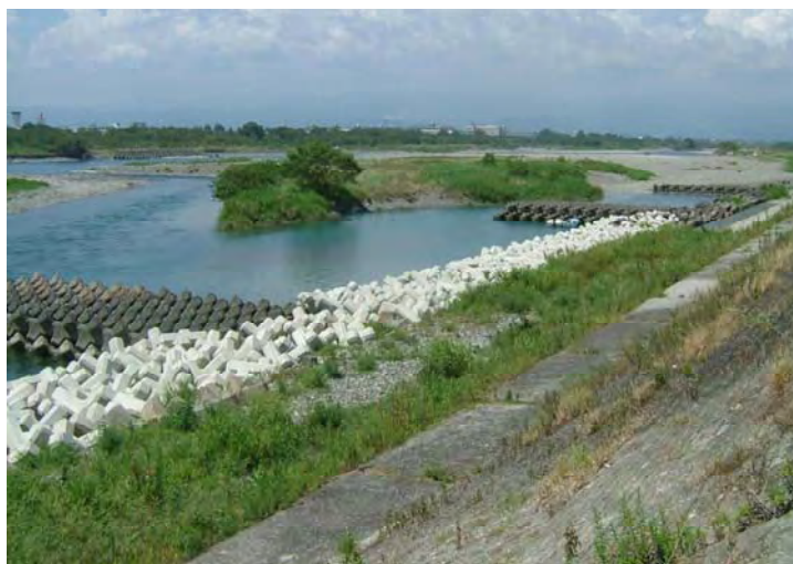
根固および水制工の設置状況
