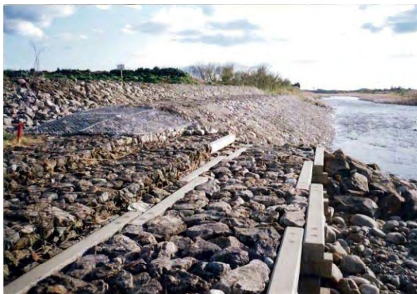
施工直後の状況
