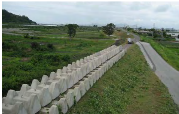
緊急復旧資材備蓄状況
