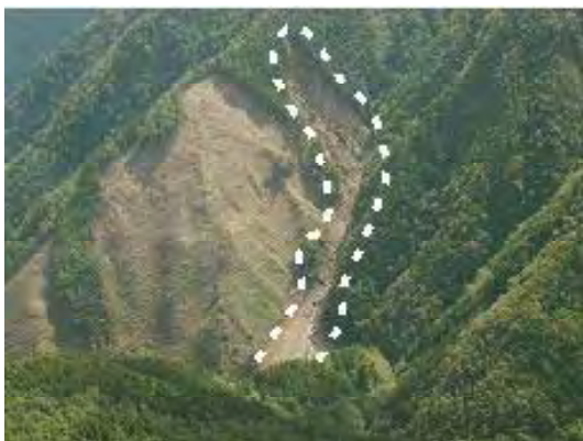
③ 別府山の崩壊状況
