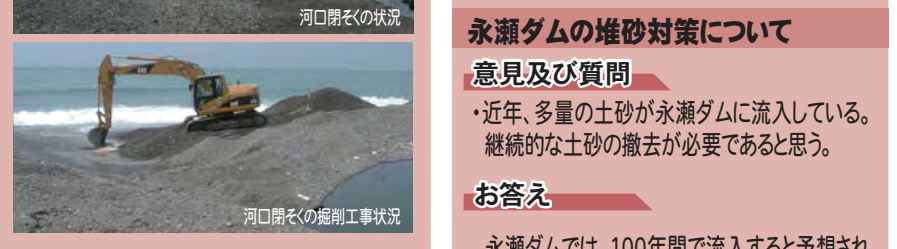
▲河口閉そくの掘削工事状況
