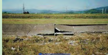
▲平成10年9月洪水による低水護岸の被災(香美市岩積地先)
