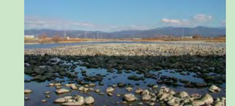
▲濁水時の状況(深瀬地点)
