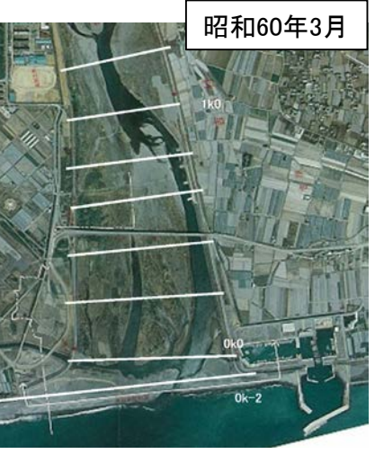
昭和58年吉川漁港導流堤の完成
