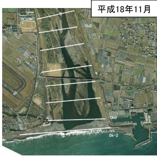
平成16～17年の3度の出水の後、河口付近のみお筋も河道中央部～右岸よりに変化
