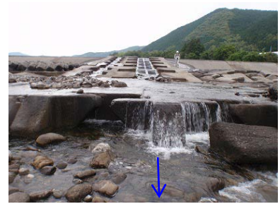
統合堰第一魚道
