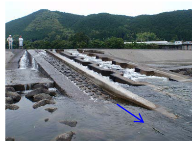
統合堰第二魚道
