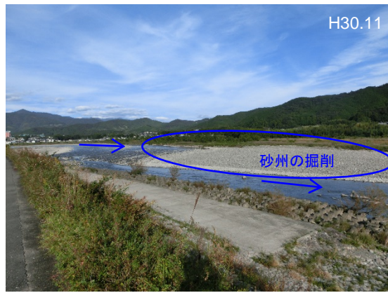
今後、河道掘削を行う予定の下ノ村地区上流の砂州 (9k/2付近の現状)
