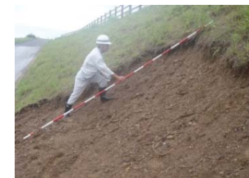
洪水時の堤防巡視
