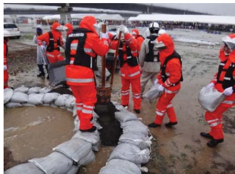
水防工法実施状況
