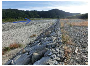
低水護岸と高水敷を整備
