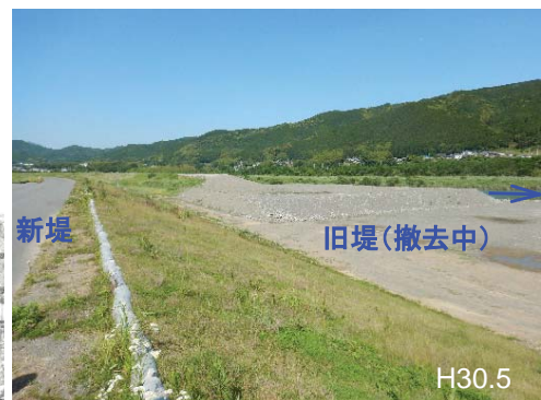
【現在の旧堤撤去状況】(8k/6付近)
