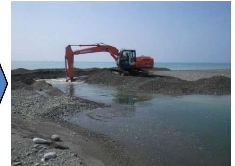
河口閉塞時の砂州の開削状況
