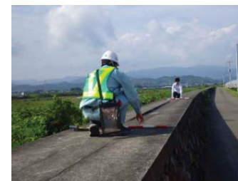
堤防(管理用水路)の点検状況
