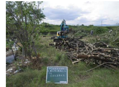
樹木伐開状況 右岸3k/4付近:平成27年度
