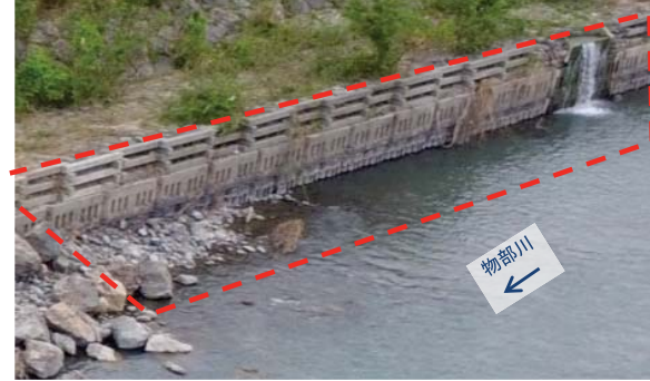
水制根固流失(箇所⑧)
