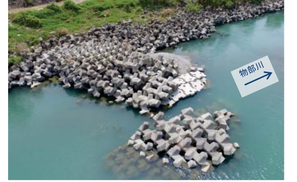
水制根固流失(箇所⑧)
