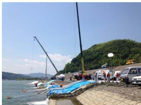
排水ポンプ車訓練を実施
