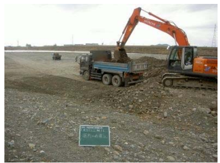
4K/0付近の河道掘削状況
