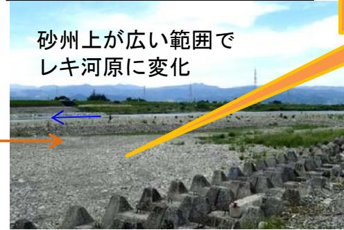
樹木伐開後（平成28年5月）
