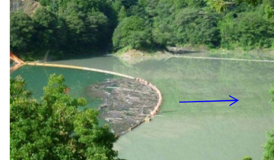
永瀬ダム分画フェンスの設置状況
