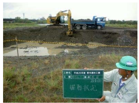
3K/4付近の河道掘削状況
