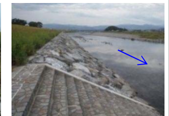
低水護岸を整備し覆土 水衝部は巨石を用いた 強固な護岸を整備
