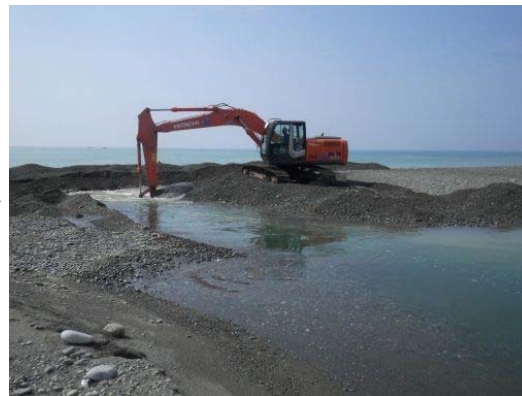
河口閉塞時の砂州の開削状況
