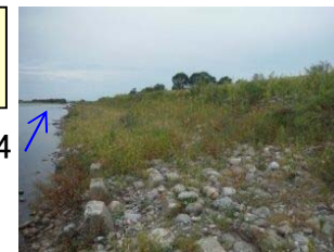
低水護岸を整備し覆土 水衝部は巨石を用いた 強固な護岸を整備
