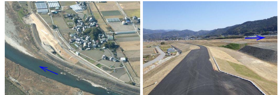
【下ノ村引堤完成写真】 (8k/6付近)
