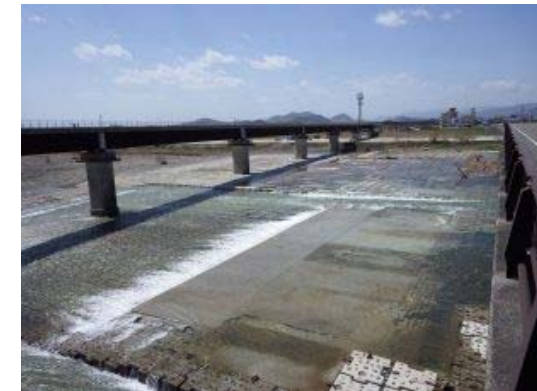
老朽化した構造物の補修 (深淵床止め：平成25年度~26年度)
