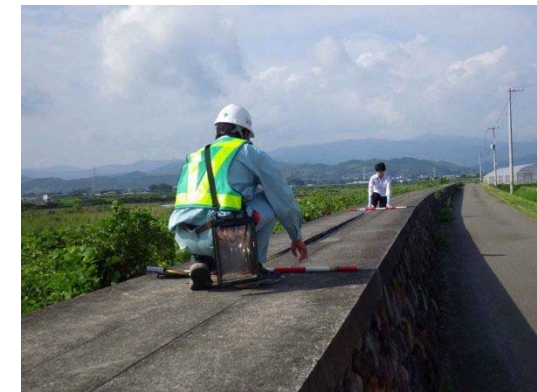
堤防(管理用通路)の点検
