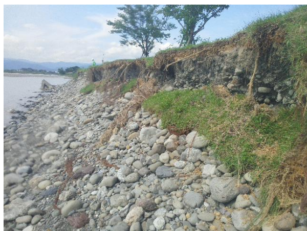
【河岸侵食(平成26台風11号 左岸深淵地先)】
