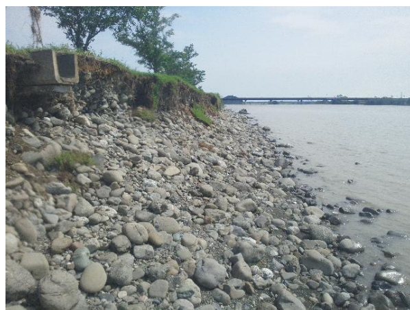
【河岸侵食(平成26台風11号 左岸深淵地先)】
