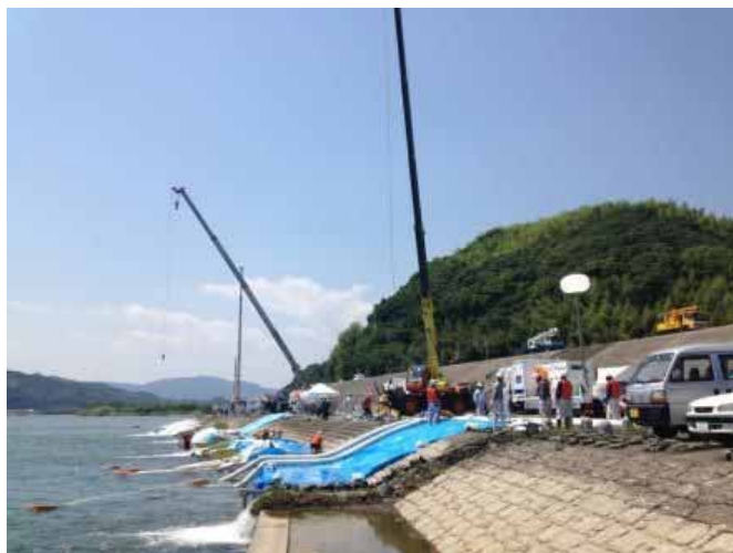
排水ポンプ車訓練を実施
