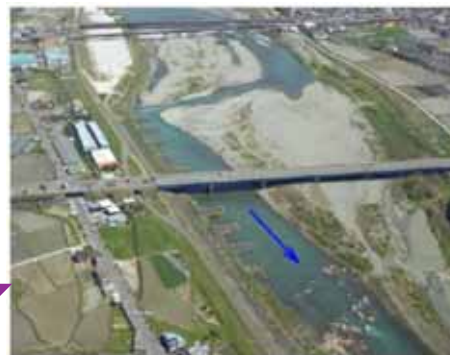
水衝部の水制群 (河口より2.8km付近)
