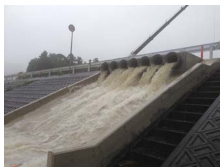
排水ポンプ車稼働状況（H26.8 台風 12 号）
