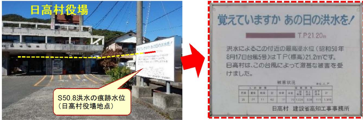
図 3.7 昭和 50 年 8 月台風 5 号の浸水痕跡水位の標示
