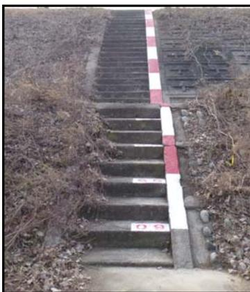
図 3.11 量水標の設置のイメージ
