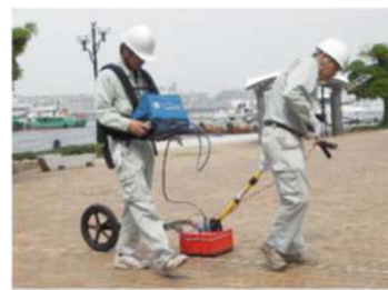
地中レーダー探査
