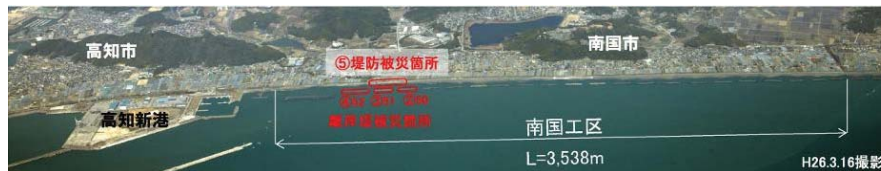
南国工区西端の被災状況(平成26年台風11号)
