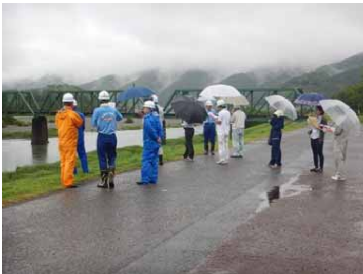
重要水防箇所の共同点検
