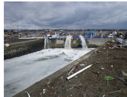
浸水エリアから排水ポンプ車で排水
