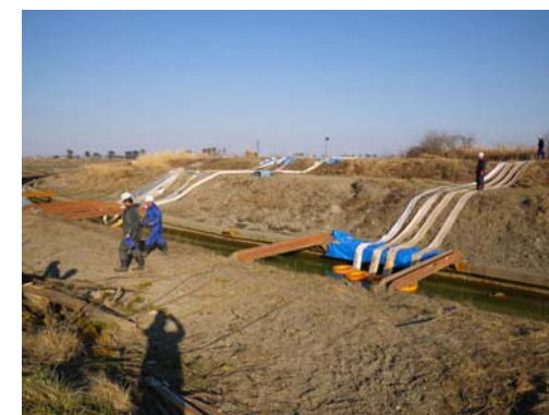
浸水エリアから排水ポンプ車で排水
