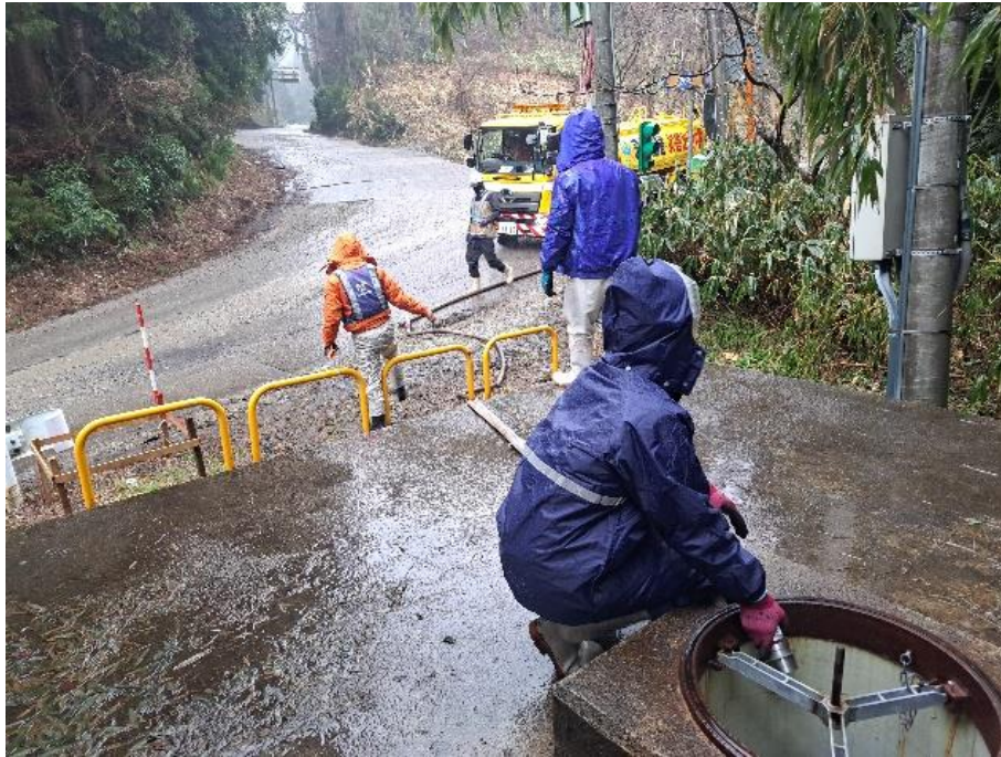
①給水支援班活動状況 (輪島市)
