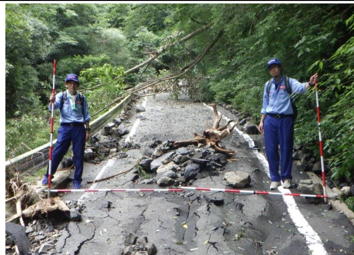
【球磨郡球磨村：被災状況調査(砂防班)】
