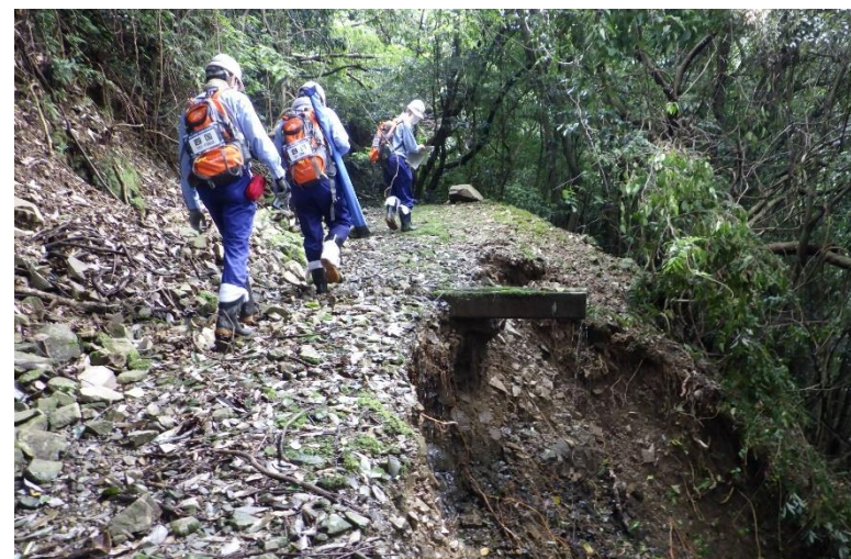
【球磨郡錦町:被災状況調査(河川班)】
