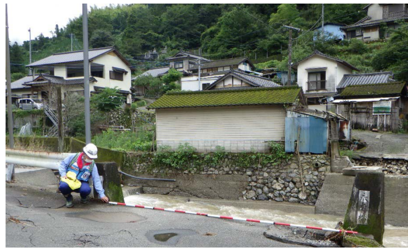
【球磨郡球磨村:被災状況調査(砂防班)】
