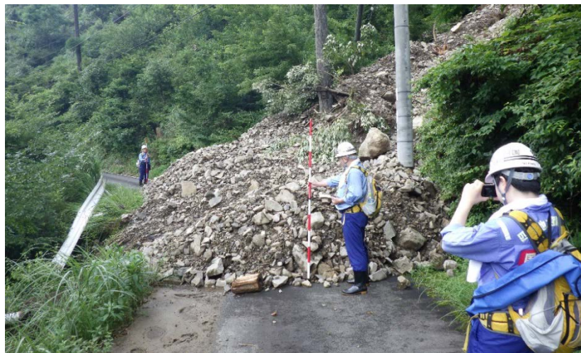
【八代市:被災状況調査(道路班)】
